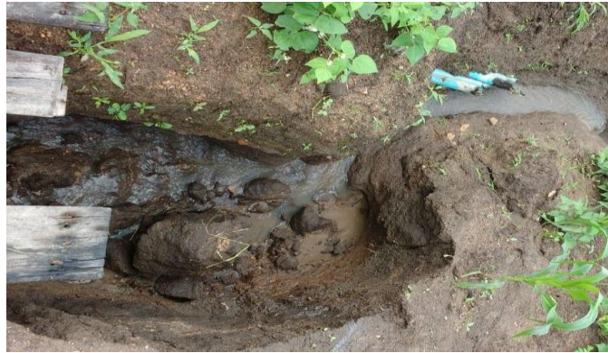
Figura 7: Esgoto não canalizado em área urbana de Boca da Mata/AL.
