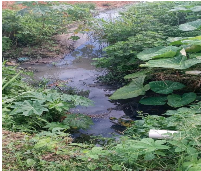
Figura 8: Esgoto a céu aberto na rua em projeto em Boca da Mata/AL.
