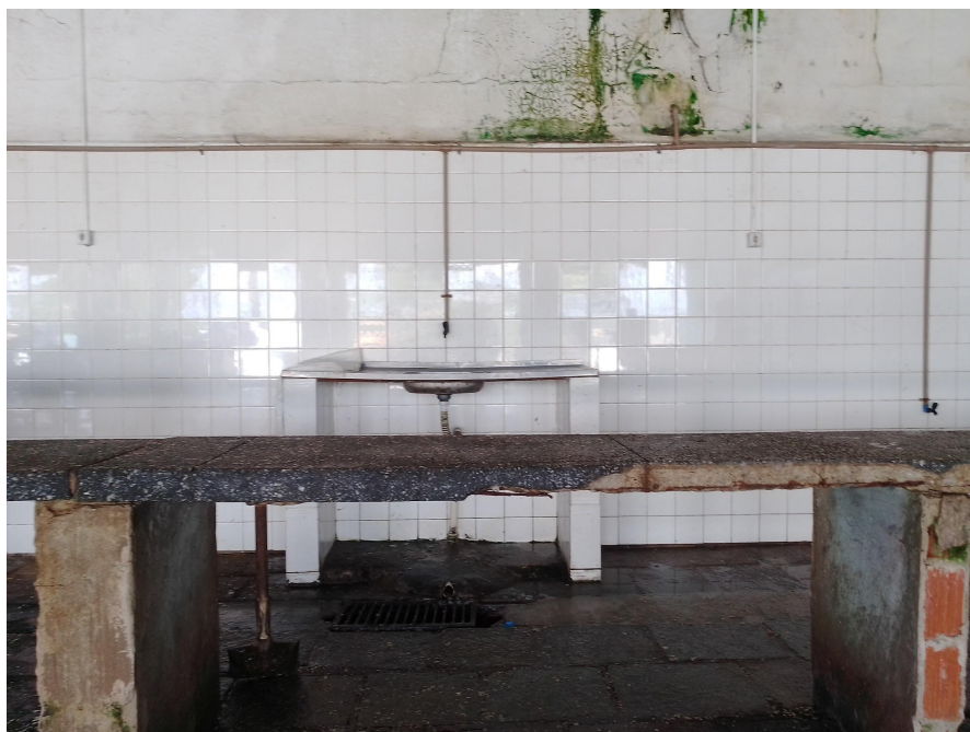
Figura 5.1.3. Interior do Mercado do Peixe, mostrando as bancadas e o lavatório com pia.
