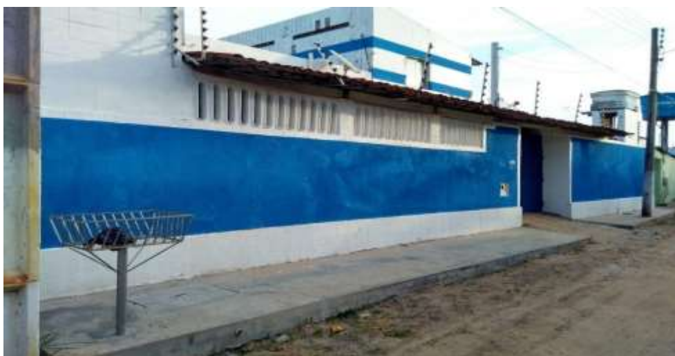
Foto 8 – Situação regular de saneamento básico.
