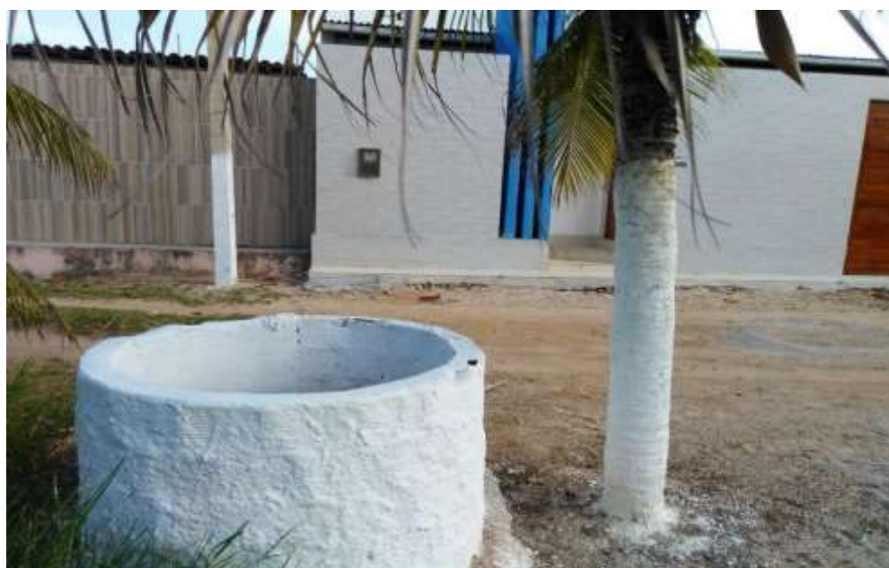
Foto 9 – Situação regular de saneamento básico.
