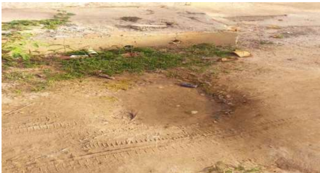
Foto 6 – Problemas no sistema de abastecimento de água.
