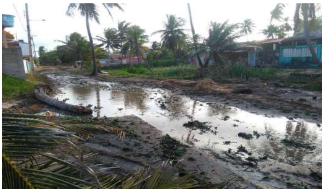
Foto 7 – Problemas de drenagem de águas pluviais.
