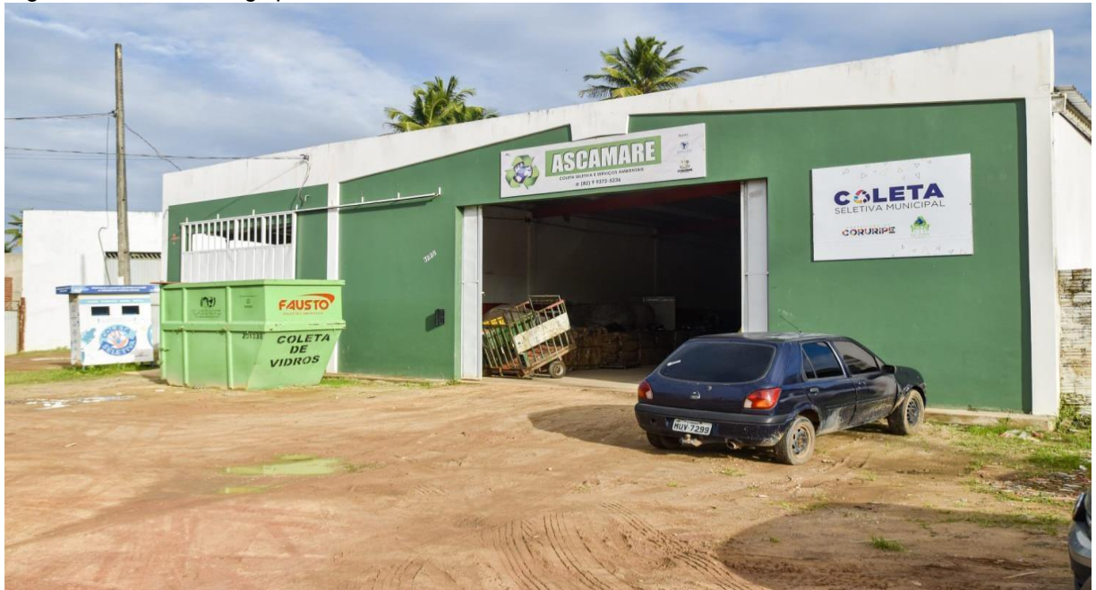
Figura 2 - Fachada do galpão de funcionamento da ASCAMARE
