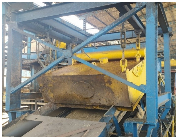
Figura 5: Eletroímã na Usina Caeté - Unidade Marituba.
