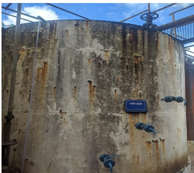
Figura 13: Tanque de produção do etanol anidro na usina Caeté – unidade Marituba.
