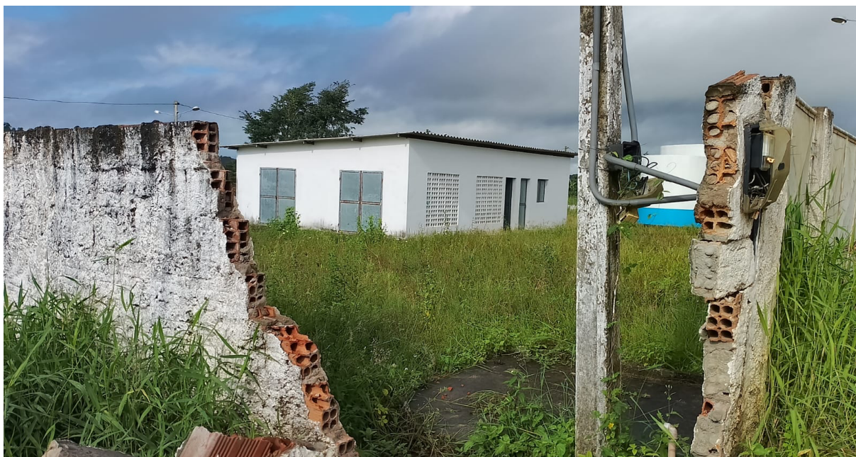
Figura 15- Estação de Tratamento de Esgoto (ETE)
