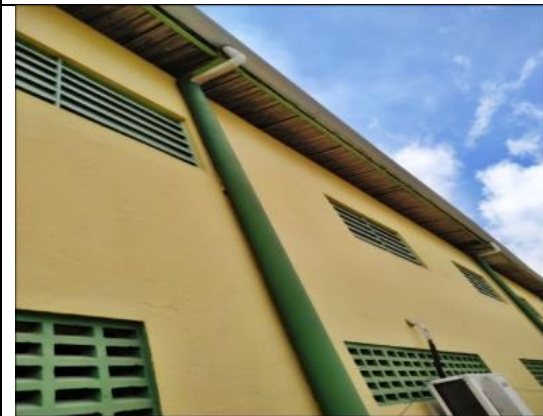
i) Instalação das Conexões
