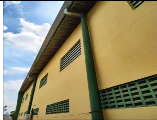
m) Ligações do Sistema Instaladas
