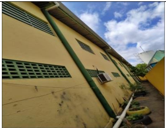
j) Calhas para a Captação
