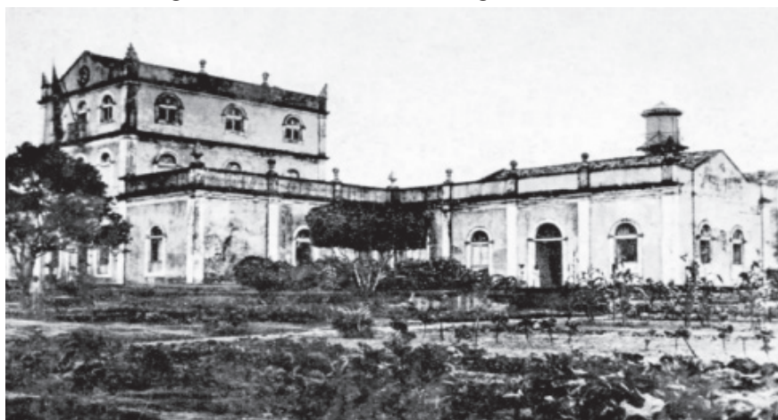
Figura 17 – Prédio do Patronato Agrícola de Satuba
