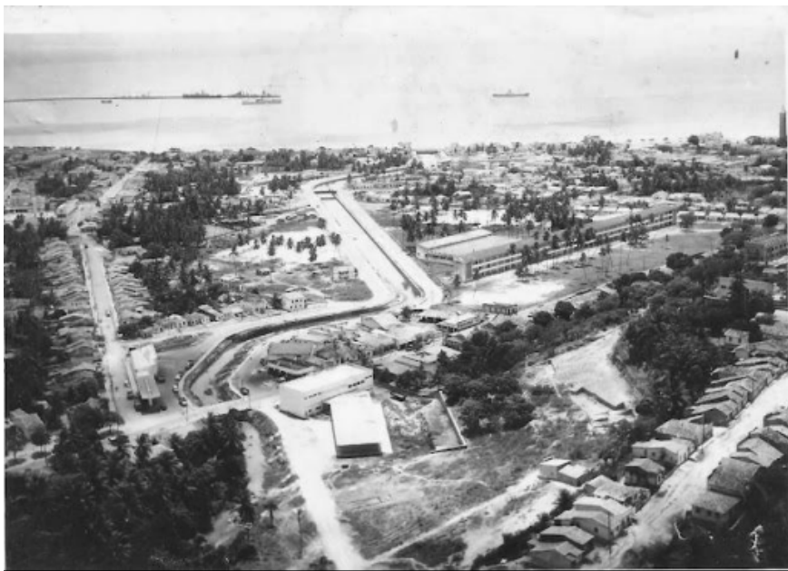
Figura 13 - Escola Industrial de Maceió na década de 1960_
