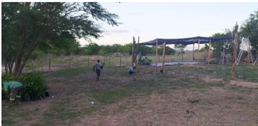
Figura 10: Construção do viveiro
