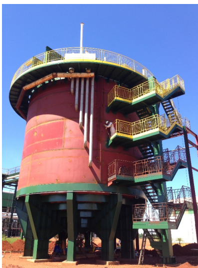
Figura 6. Decantador de Caldo do tipo Dorr
