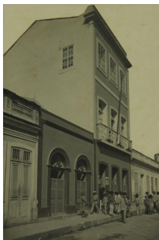
Figura 2 Primeiro prédio da Escola de Aprendizes e Artífices
