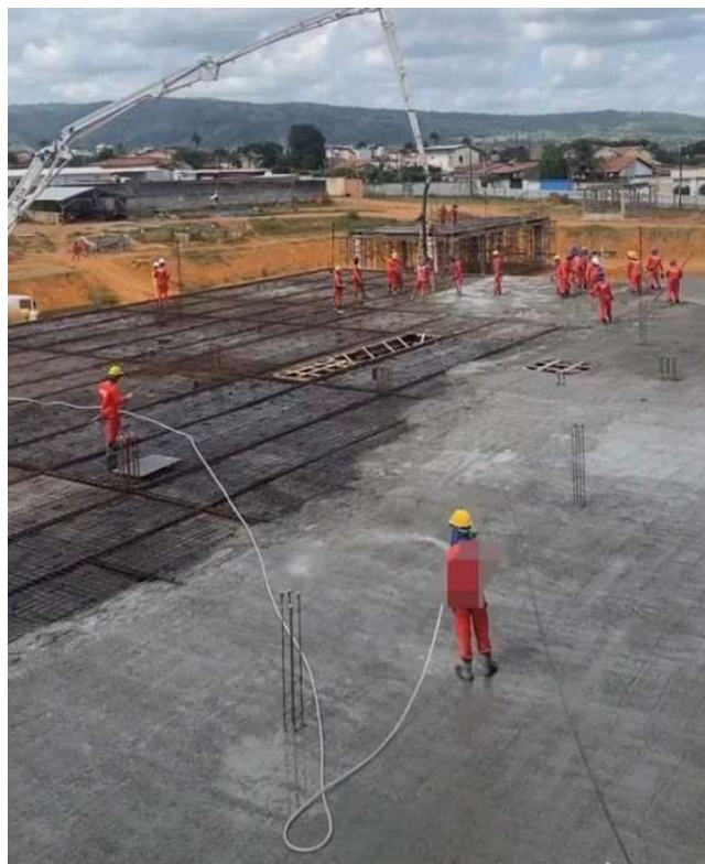
Figura 12 – Cura do concreto
