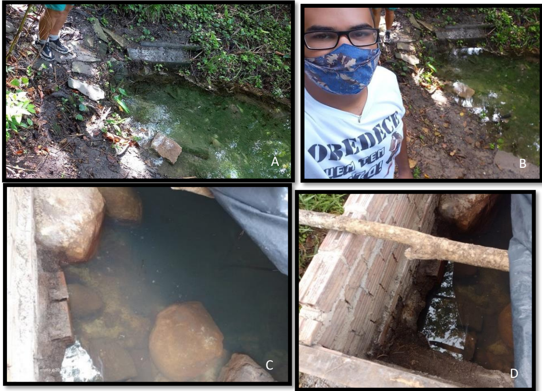
Figura 4. Nascente no Povoado Brejo dos Vieiras, União dos Palmares – AL. (B) Caracterização das Nascentes utilizadas pelos moradores do Povoado Brejo dos Vieiras, União dos Palmares; (C e D) – Reservatório (Cacimba) utilizado para armazenamento de água no Povoado.
