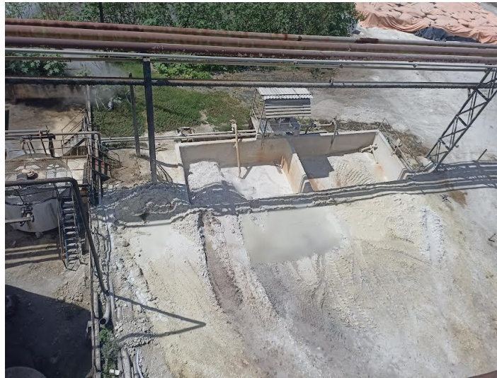
Figura 15: Tanque de preparo da cal.
