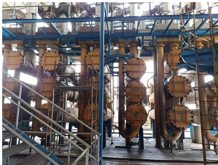
Figura 16: Aquecedores de caldo caleado.
