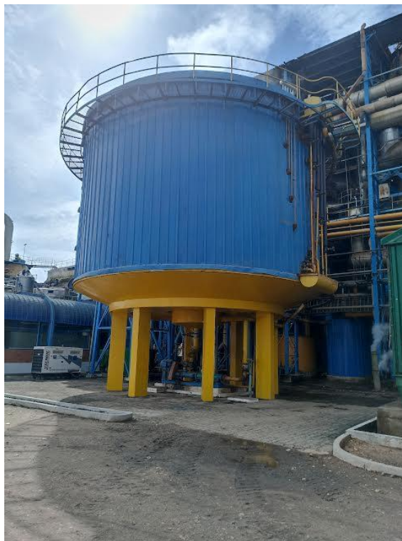
Figura 19: Decantador.
