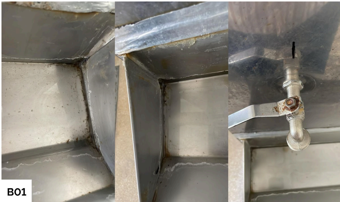
Figura 5 - Condições externas do bebedouro B01 - Pavimento térreo
