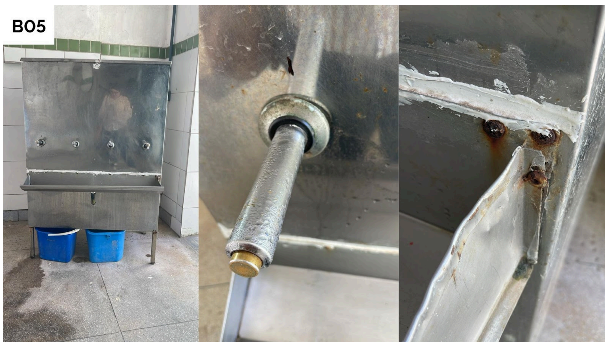
Figura 12 - Condições externas do bebedouro B05 - Pavimento térreo
