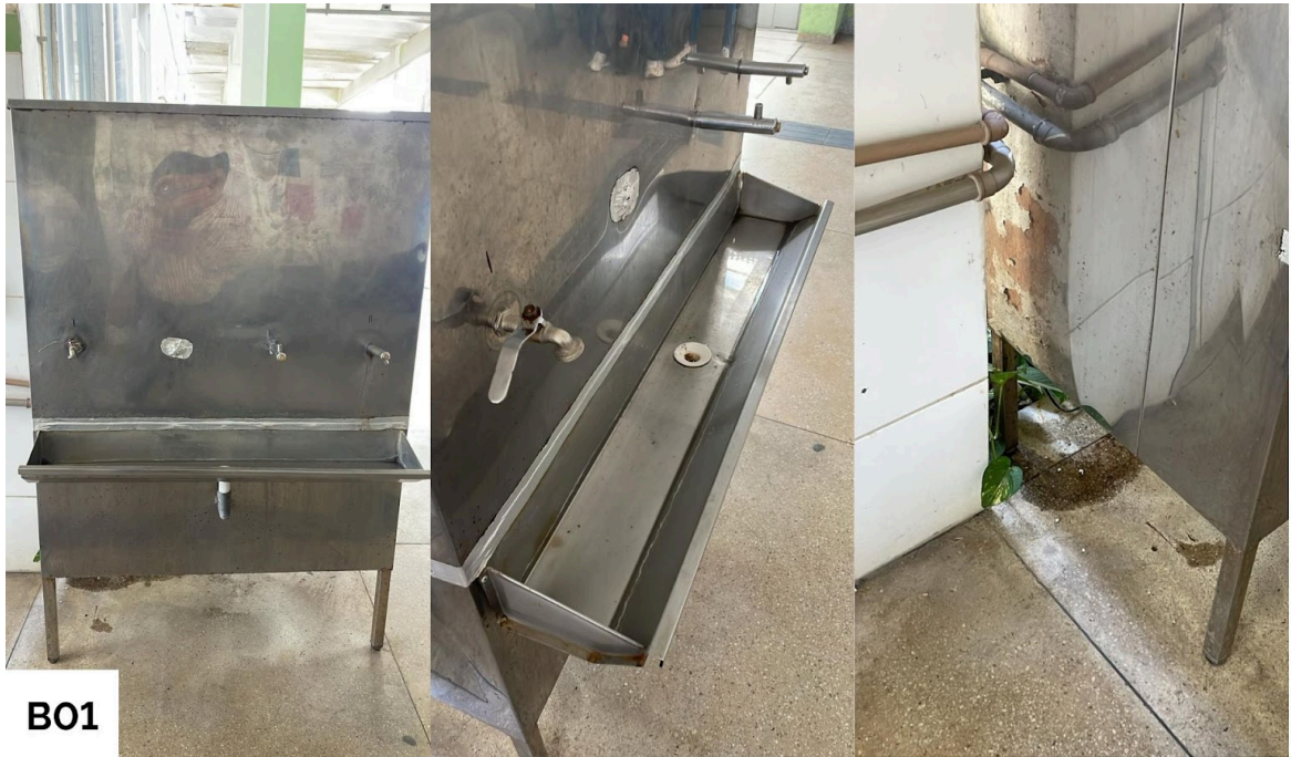
Figura 3 - Condições externas do bebedouro B01 - Pavimento térreo
