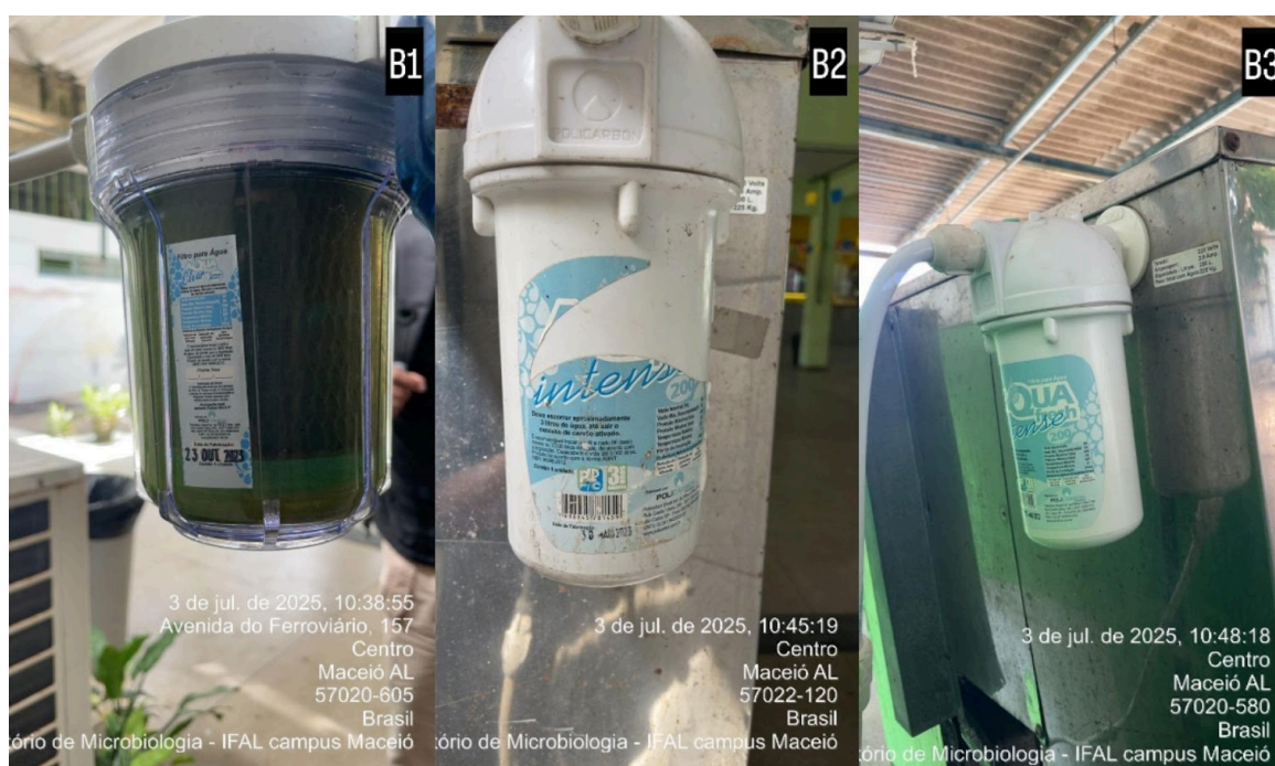
Figura 15 - Condições dos filtros dos bebedouros (B01, B02 e B03) no levantamento inicial (julho/2025).
