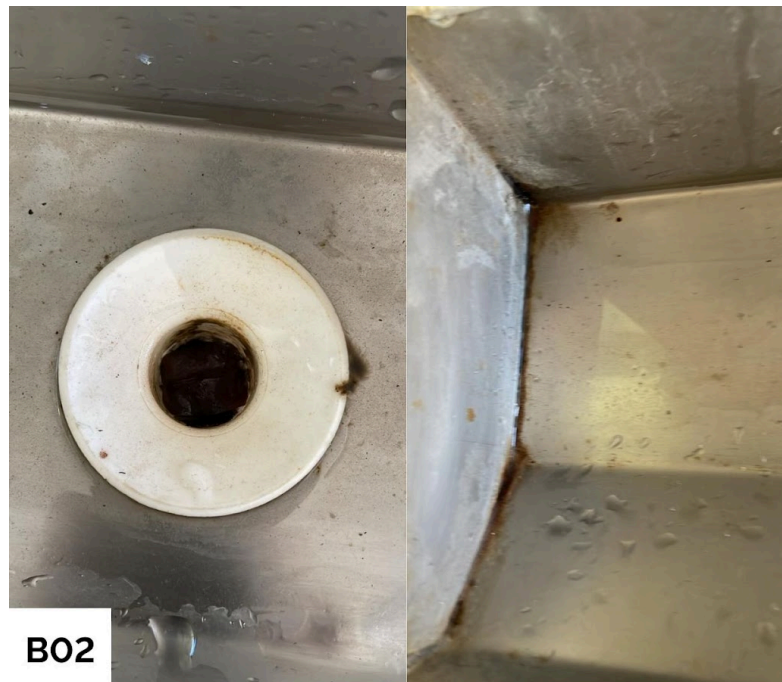
Figura 8 - Condições externas do bebedouro B02 - Pavimento térreo
