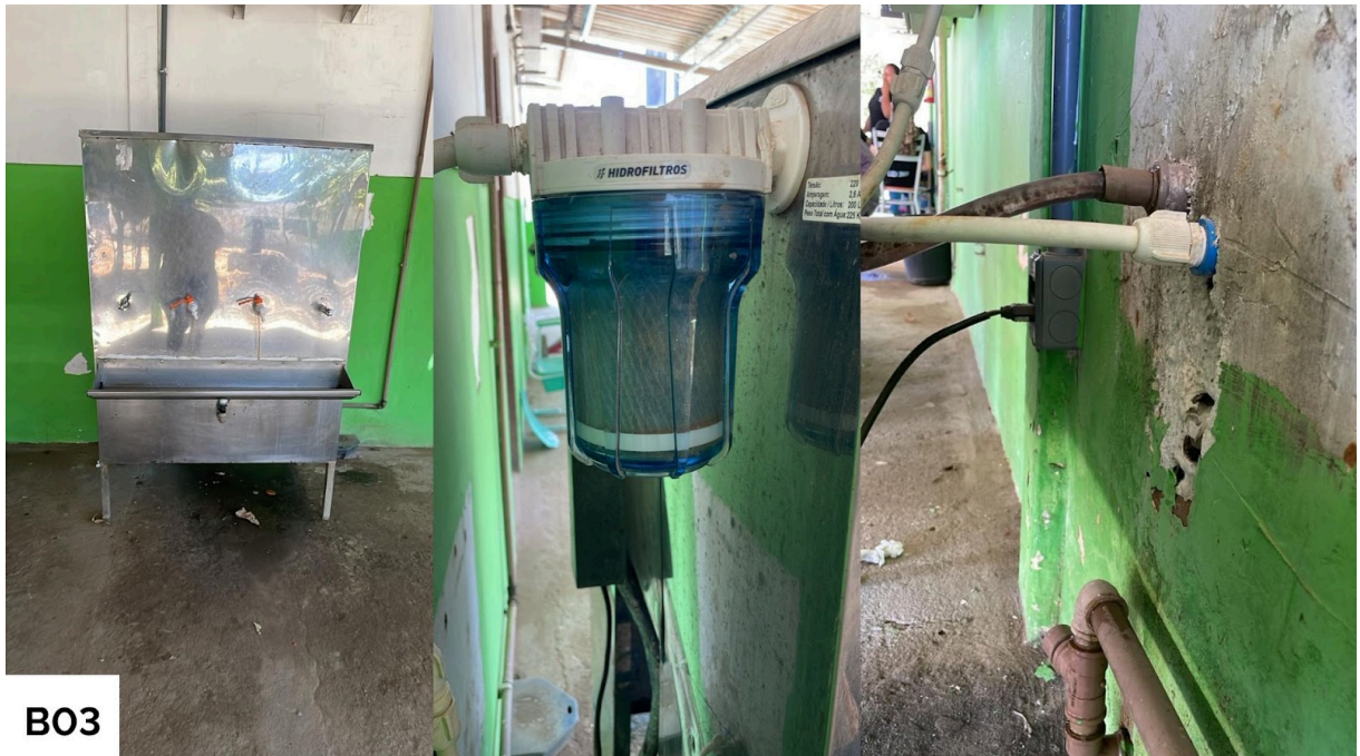
Figura 10 - Condições externas do bebedouro B03 - Pavimento térreo
