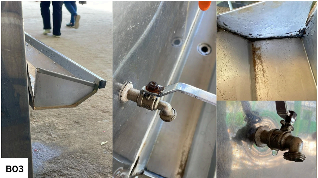
Figura 9 - Condições externas do bebedouro B03 - Pavimento térreo
