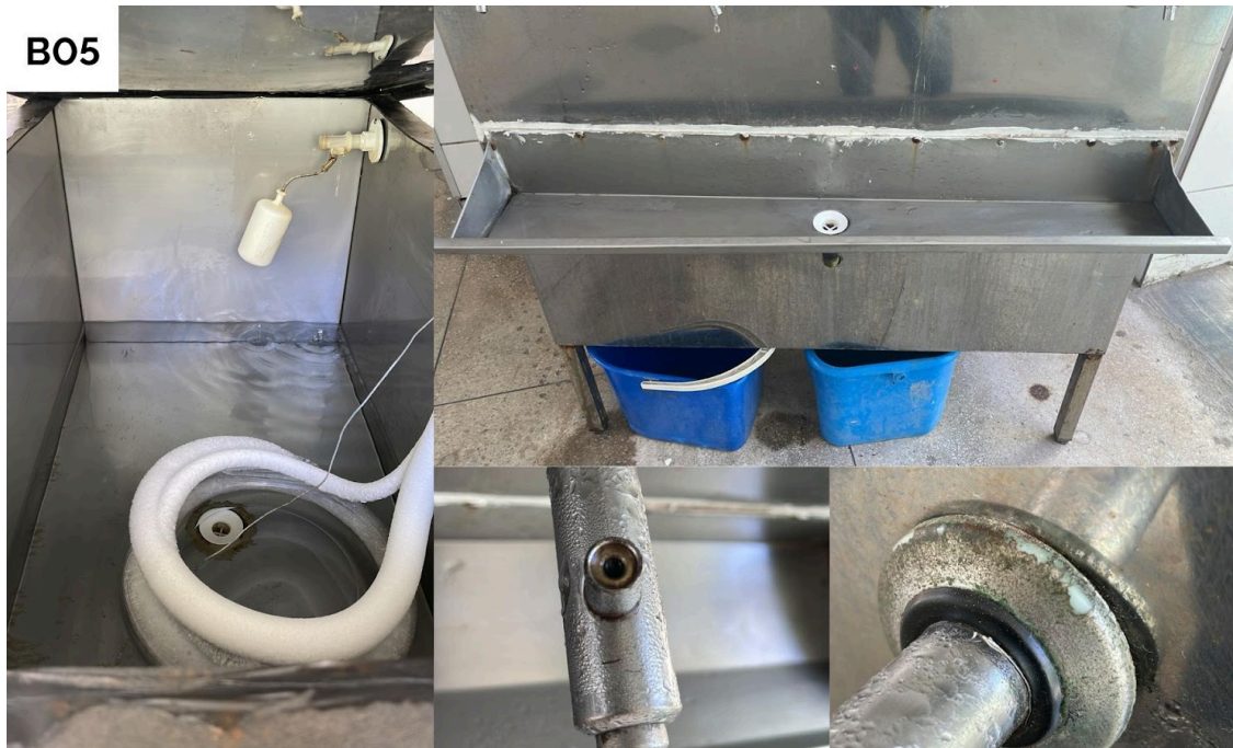
Figura 13 - Condições externas do bebedouro B05 - Pavimento térreo
