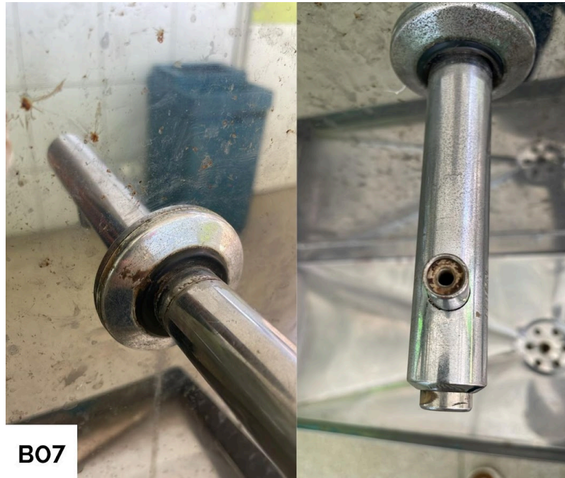
Figura 15 - Condições externas do bebedouro B07 - 1º pavimento
