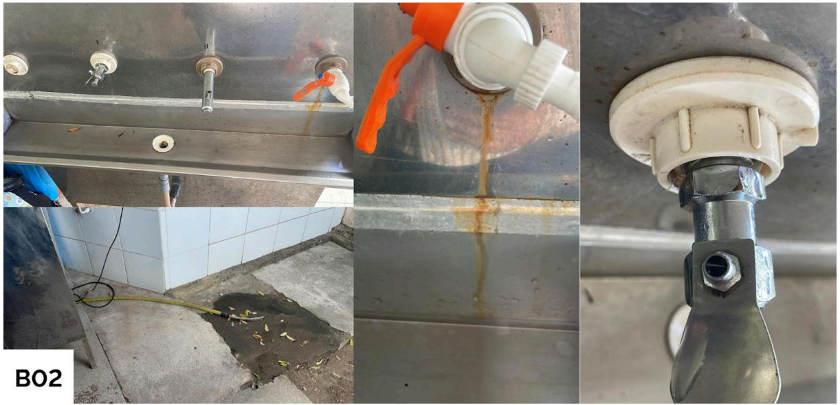
Figura 7 - Condições externas do bebedouro B02 - Pavimento térreo
