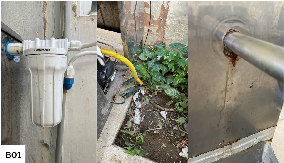
Figura 4 - Condições externas do bebedouro B01 - Pavimento térreo
