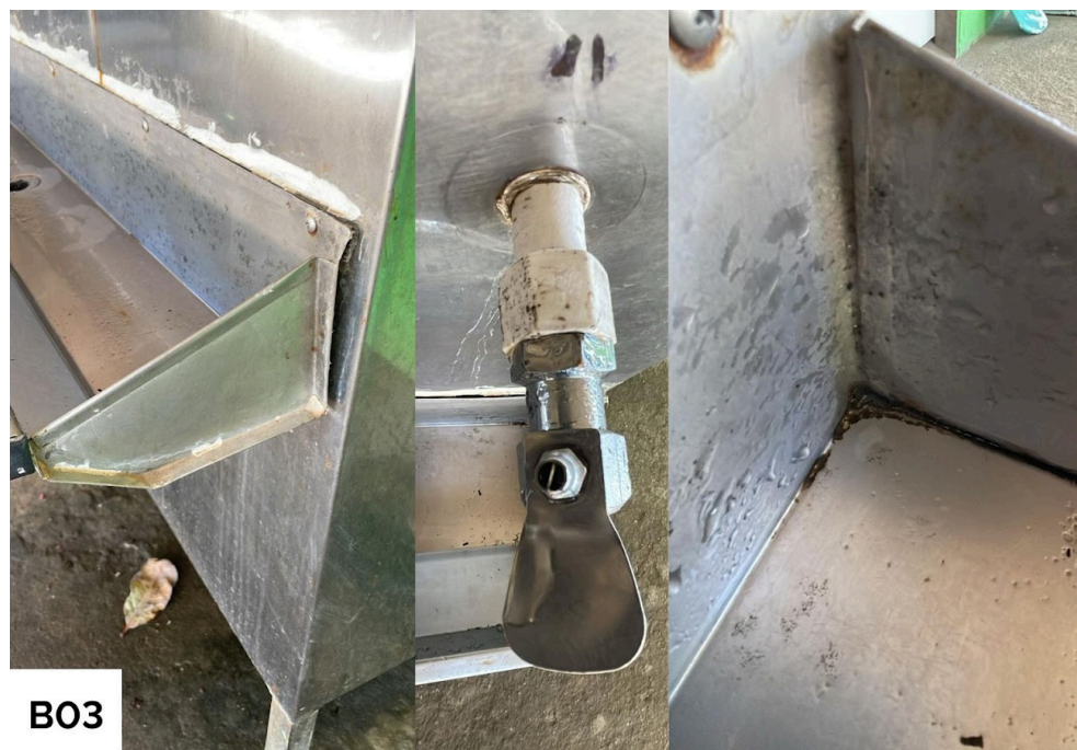
Figura 11 - Condições externas do bebedouro B03 - Pavimento térreo
