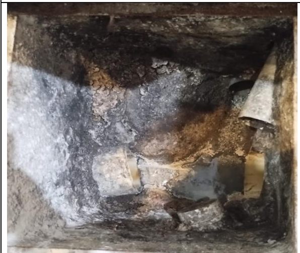
Foto 03: Caixa de inspeção
