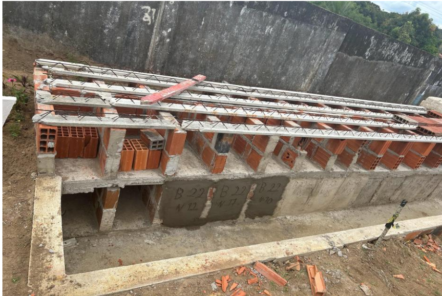
Figura 26 - Construção de ossários
