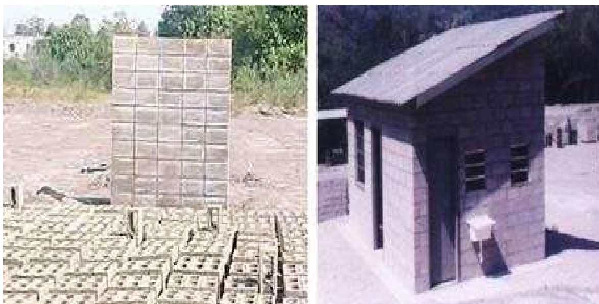
Figura 5 – Blocos e casa popular, feitos a partir do material de demolição do Edifício Andorinhas
