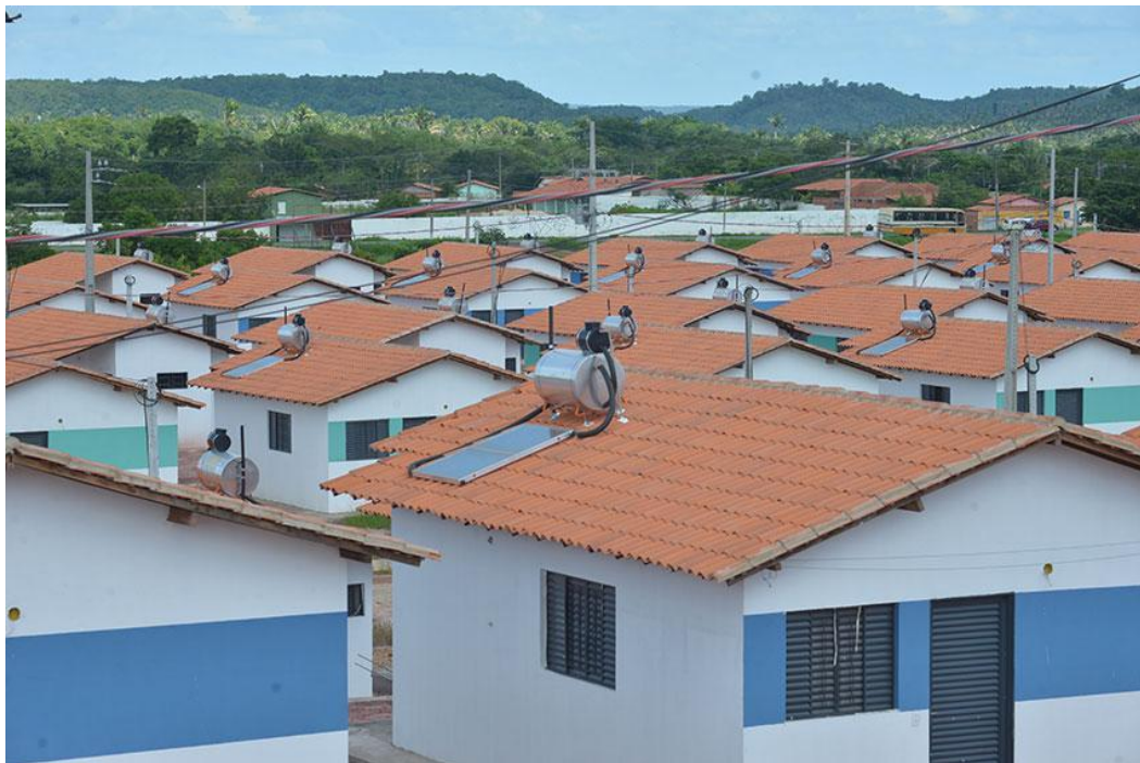
Figura 2 – Sistema de aquecimento solar
