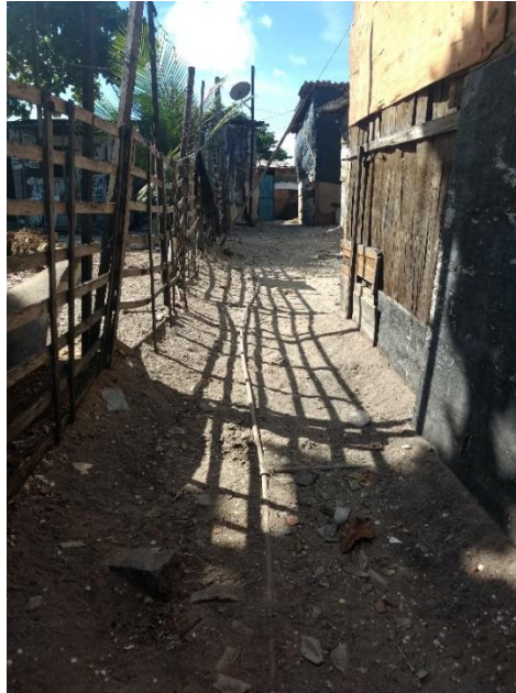
Figura 17 – Tubulações para abastecimento de água
