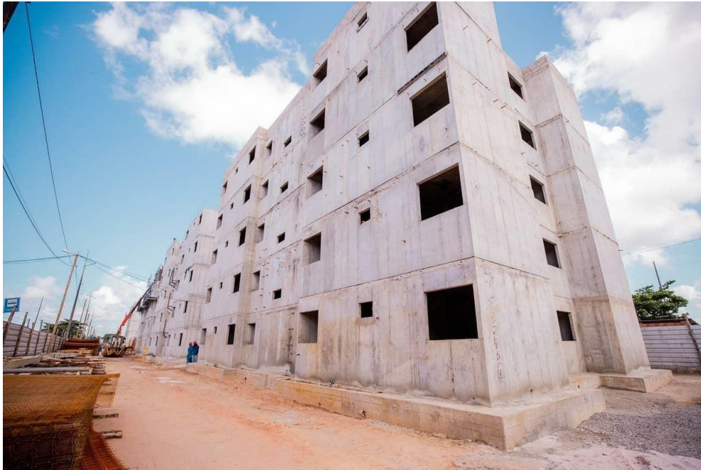
Figura 22– Paredes em concreto moldadas “in loco”
