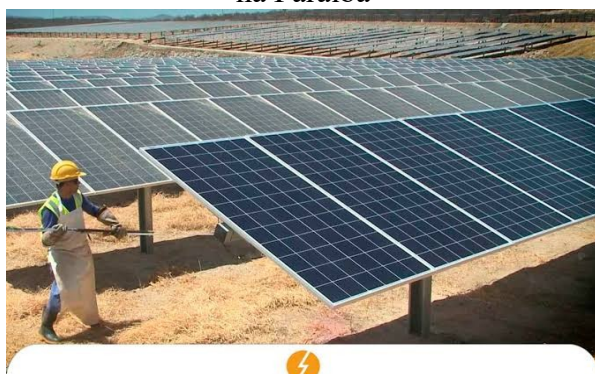
Figura 4 - Construção dos parques de geração de energia solar Luiza II e III, em Santa Luzia na Paraíba
