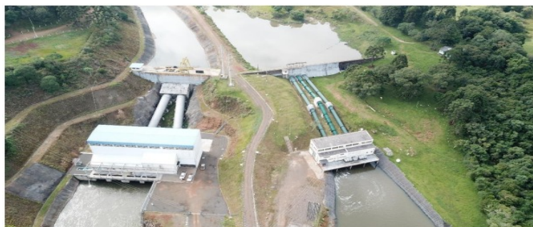
Figura 3 - Conductor forçado metálico, Usina PERY, I e II, Curitiba SC
