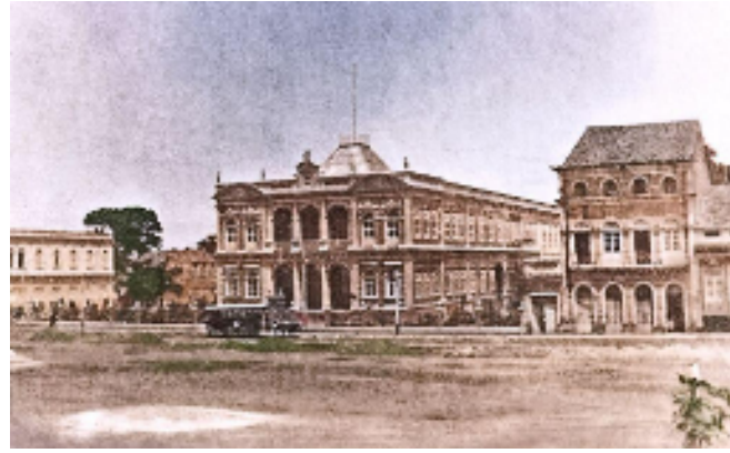
Figura I5: A Escola Central de Maceió
