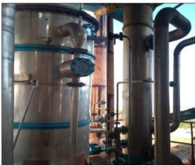
Figura 12- Decantador e coluna P, componentes da coluna C.
