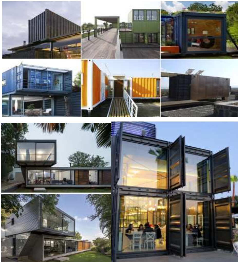
Figura 3 - Painel com Construções em Containers.
