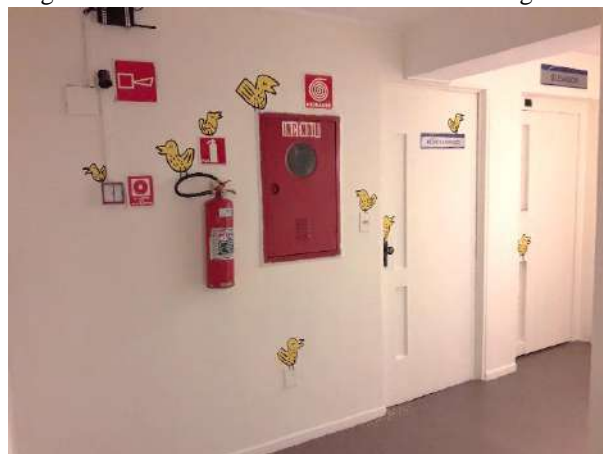
Figura 131 – Vista lateral direita com acesso à galeria.
