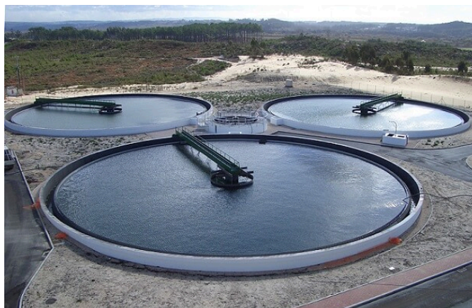
Figura 4: Decantadores circulares.
