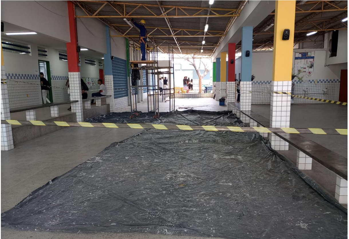
Imagem 5 – interior da escola, espaço ocupado pela reforma.
