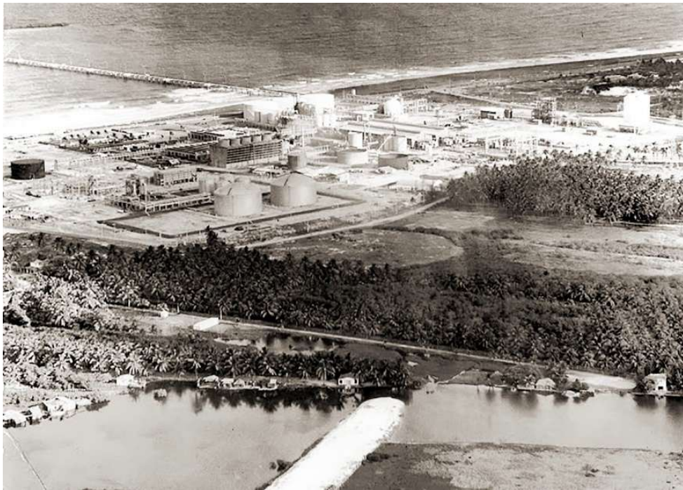
Figura 7. Vista aérea da implantação da Salgema Indústrias Químicas no bairro do Pontal da Barra em Maceió, Alagoas
