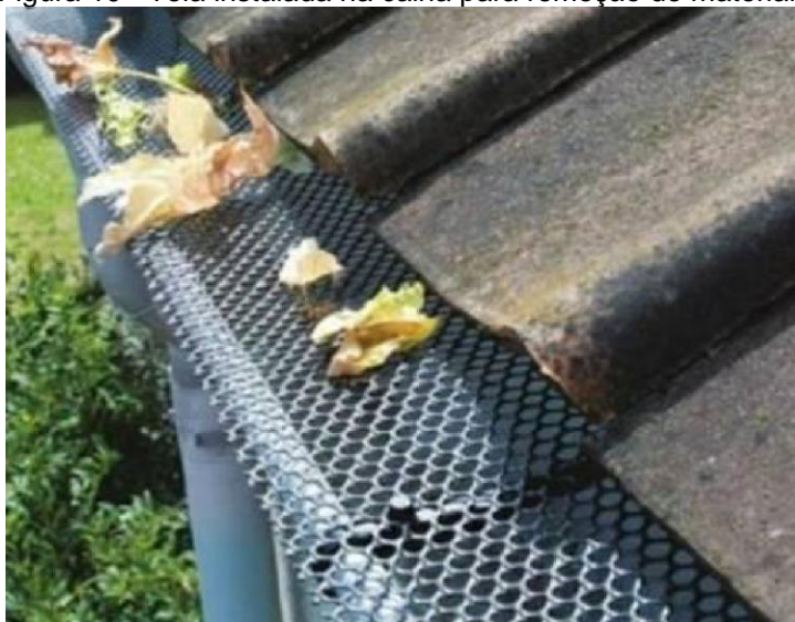
Figura 10 - Tela instalada na calha para remoção de materiais
