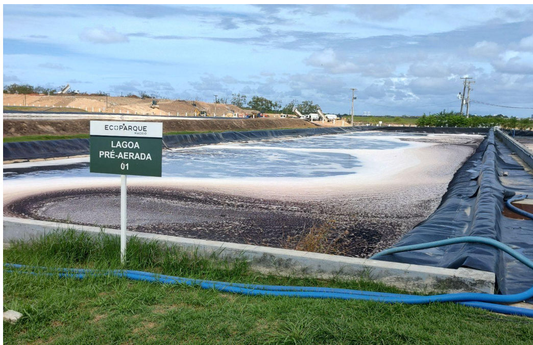
Figura 21 - Lagoa pré-aerada na estação de tratamento de chorume do CTR de Maceió.
