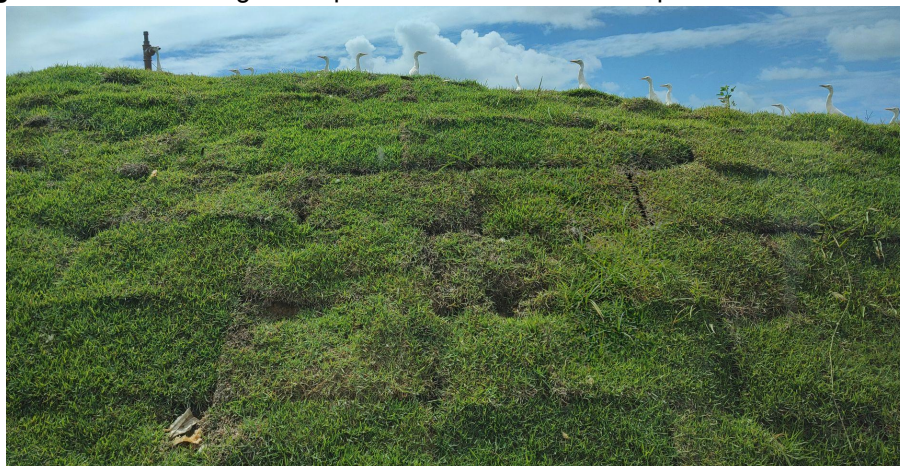
Figura 16 - Placas de grama aplicadas sobre taludes compactados no CTR de Maceió.
