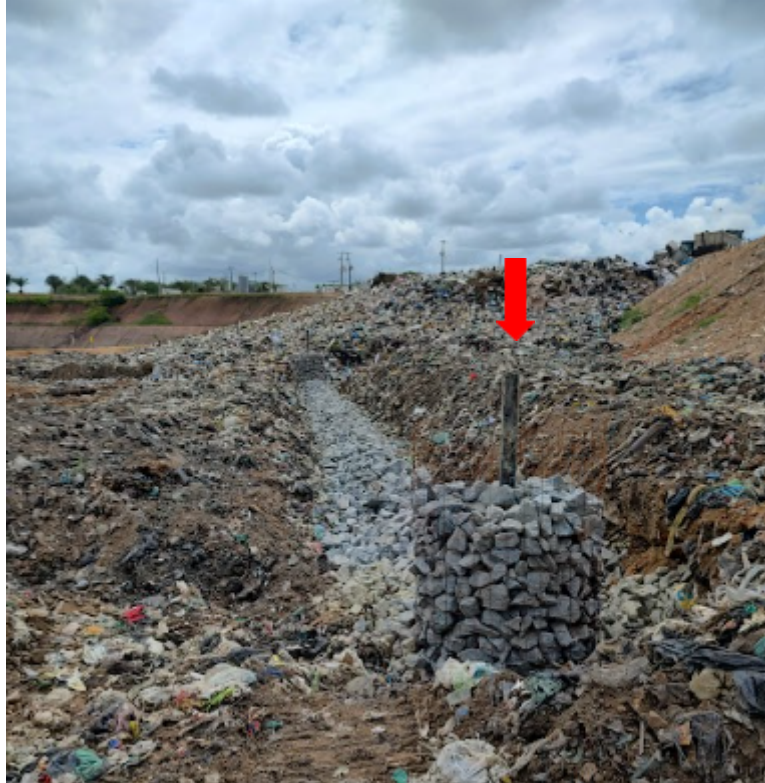
Figura 28 - Gaiola de espera para controle de pressão do chorume no CTR de Maceió.
