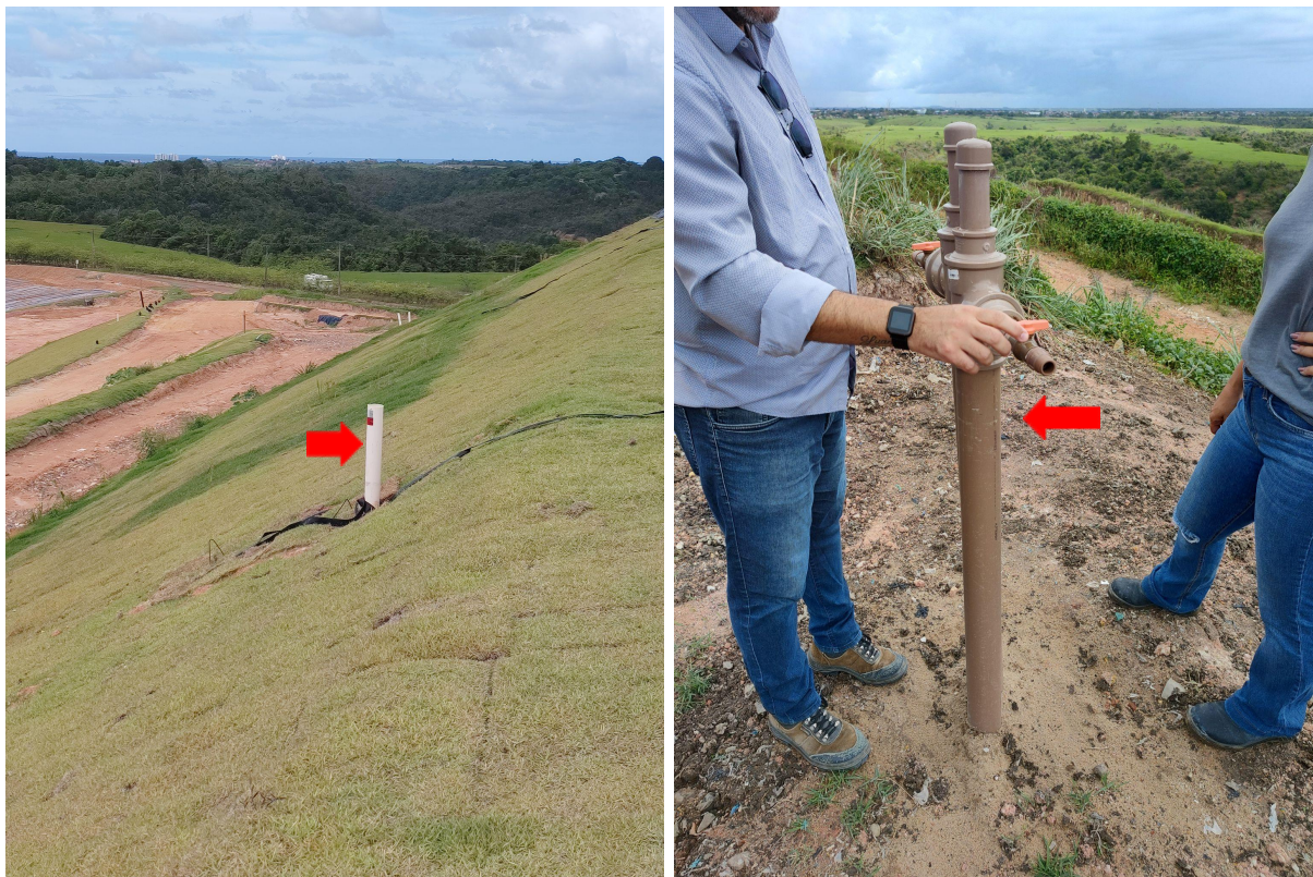
Figura 24 - Instrumento geotécnico e placa de recalque no CTR de Maceió.
