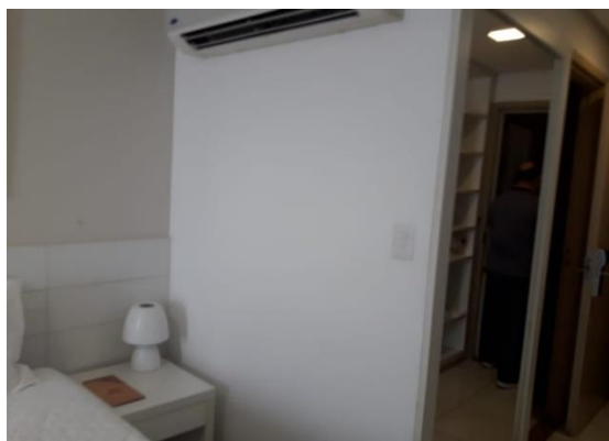
Figura 21 - Vista da parede do banheiro
