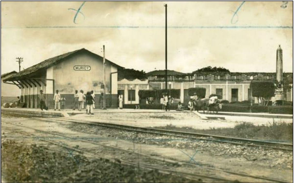
Figura 6: Praça João Pessoa: Estação Companhia Ferroviária do Nordeste, Murici-AL.
