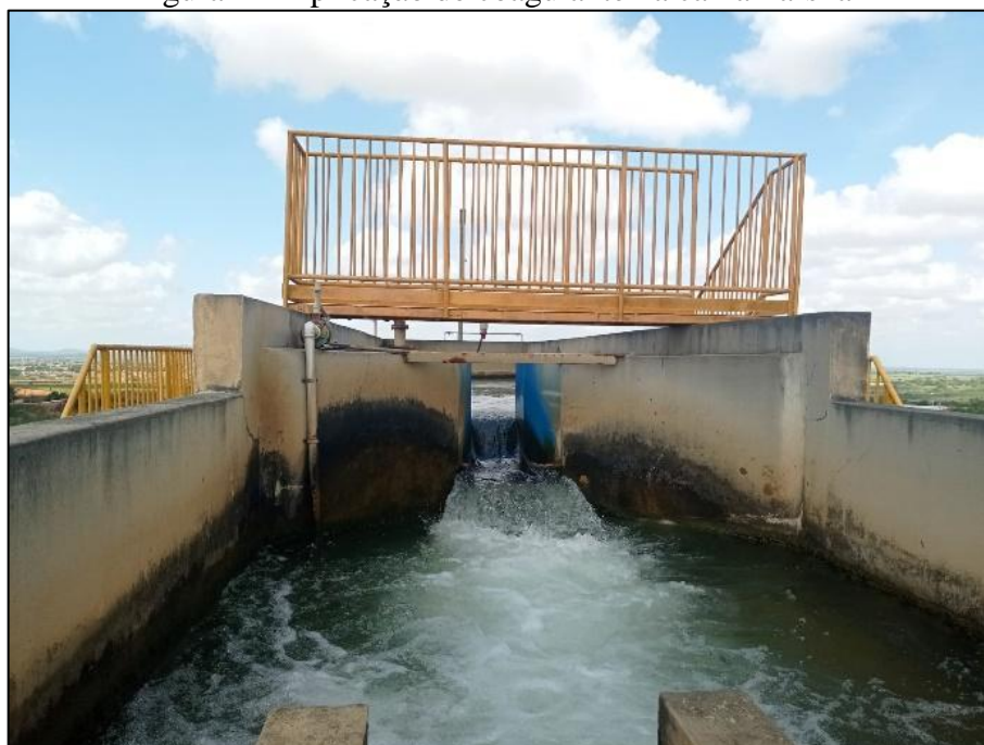
Figura 4 – Aplicação de coagulante na calha Parshall
