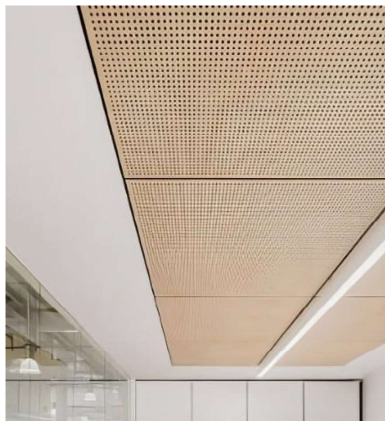
Figura 10 - Paineis de madeira perfurada
