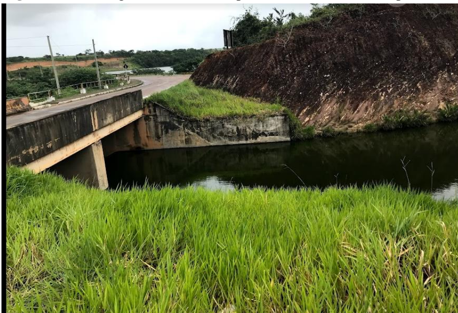
Figura 07 – Barragem localizada no povoado Bananeiras, Arapiraca-AL.
