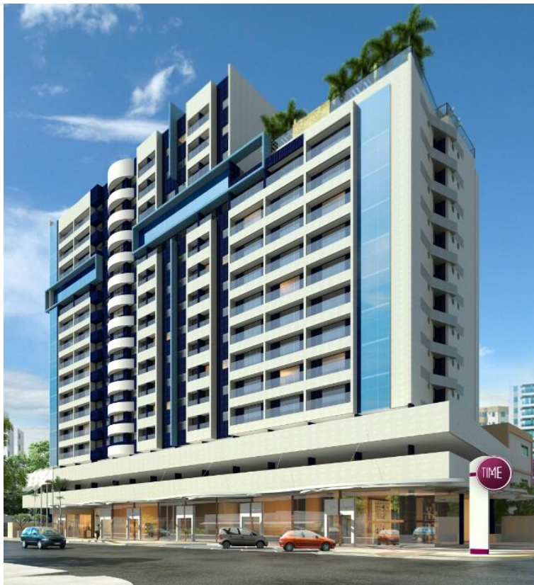
Figura 15 - Fachada Edifício Time
