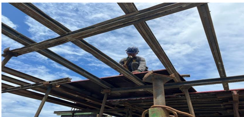
Foto 05 – Execução de assoalho
