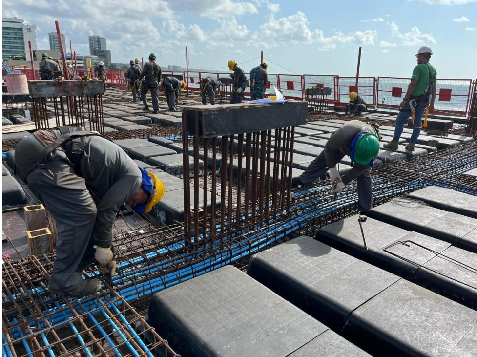
Foto 11 - (montagem de armação na laje)
