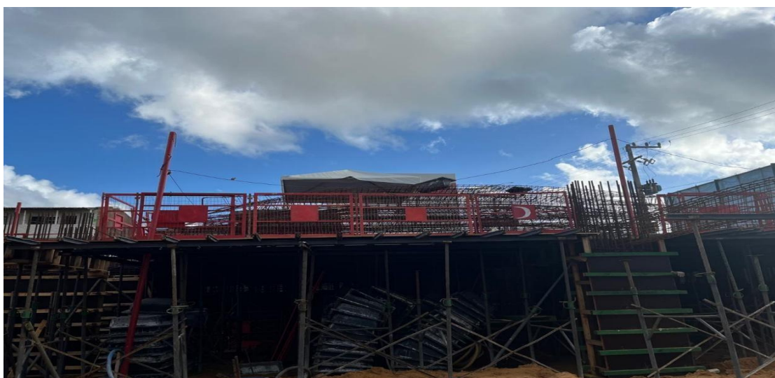
Foto 09 – Guarda-corpo e linha de vida (pilotes)
