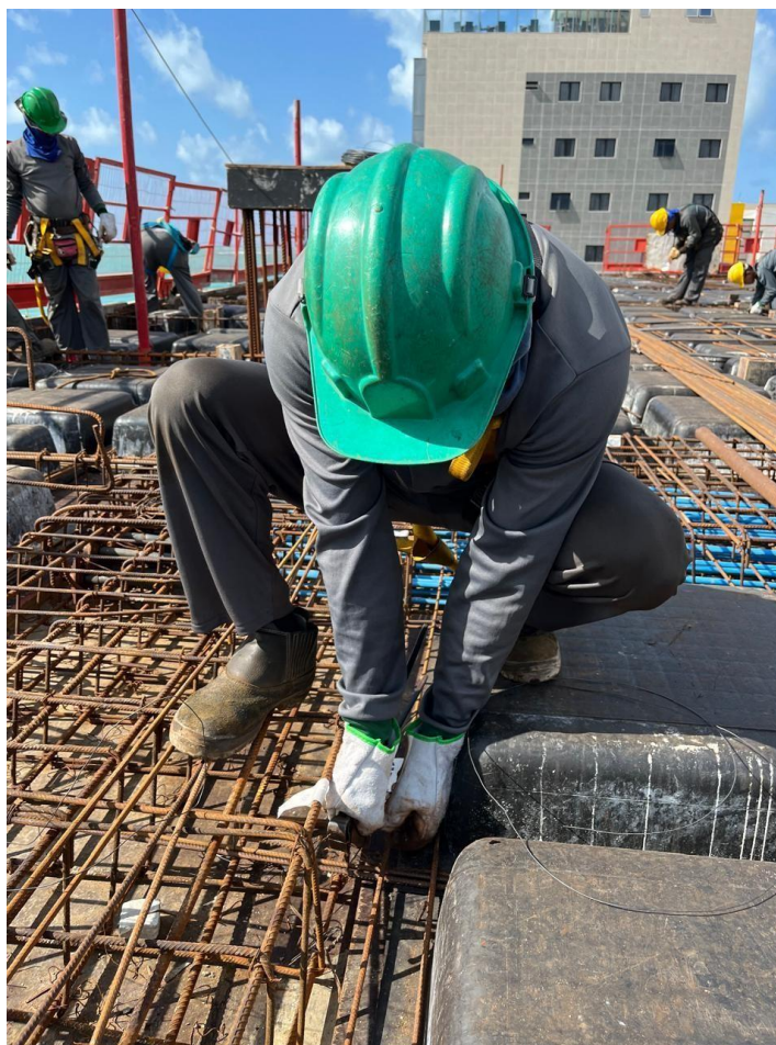
Foto 10 - Armador fazendo as amarrações das ferragens
