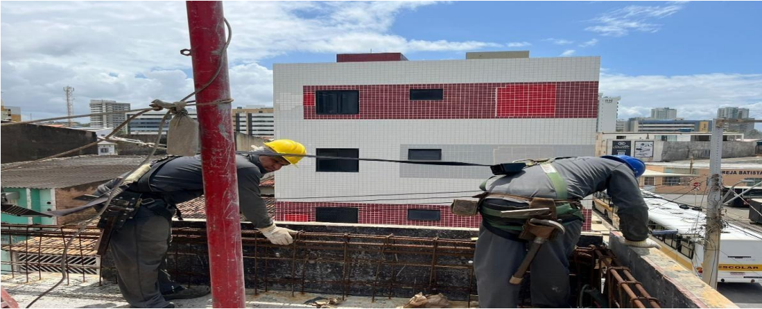
Foto 07 – Execução de forma
