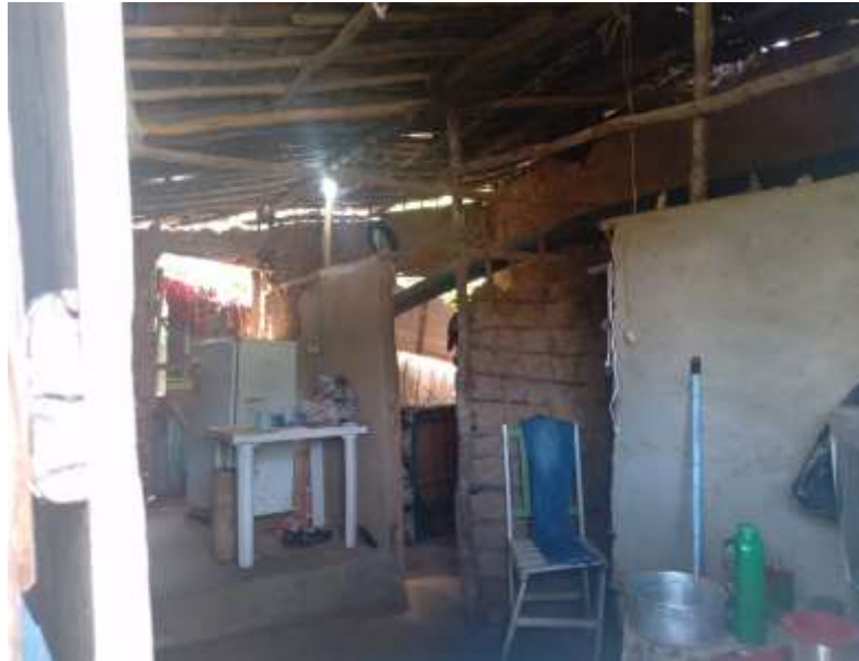
FIGURA 16 – INTERIOR DE UMA CASA DE TAIPA NO POXIM ATUAL
