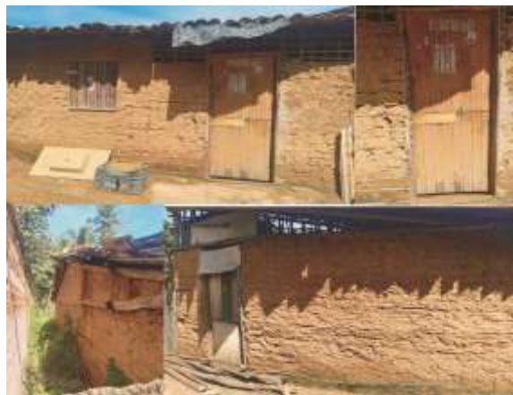
FIGURA 9 – CASA DE TAIPA NO POXIM ATUAL 29
