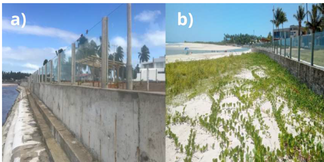
Figura 50 - a) Bagwall construído na praia de Costa Brava, em 2020; b) Deposição natural de sedimentos após instalação da contenção, em 2023.
