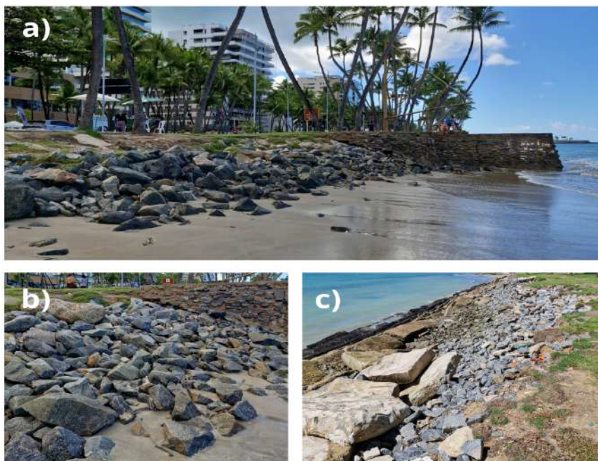
Figura 17 - a) e b) enrocamento de pedras localizado na Praia da Ponta Verde; c) outra estrutura de enrocamento associada a bolsacreto.
