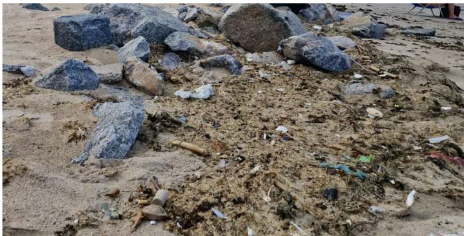
Figura 19 - Presença de lixo acumulado na contenção.
