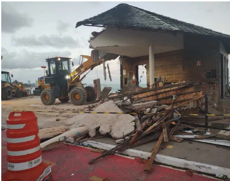
Figura 10 - Barraca Buenos Aires sendo demolida.
