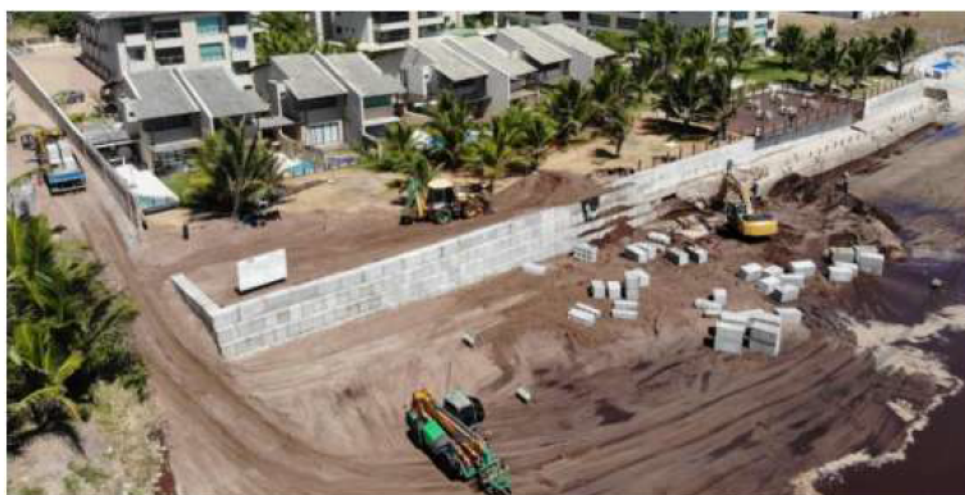
Figura 33 - Execução da contenção marítima / Ipojuca -PE.
