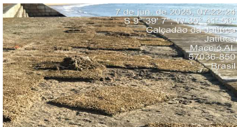
Figura 47 - Grama morta devido ao alagamento e salinidade da água do mar.
