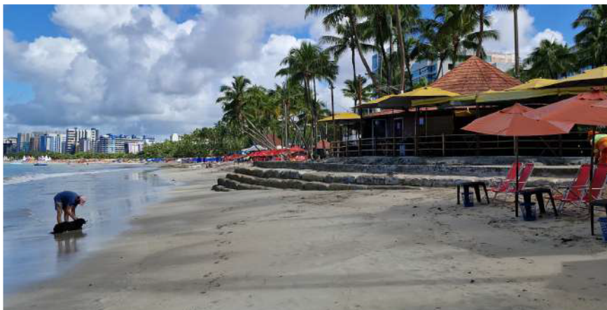
Figura 15 - Vista ao norte da estrutura que dá acesso ao estabelecimento Clube do Pirata.
