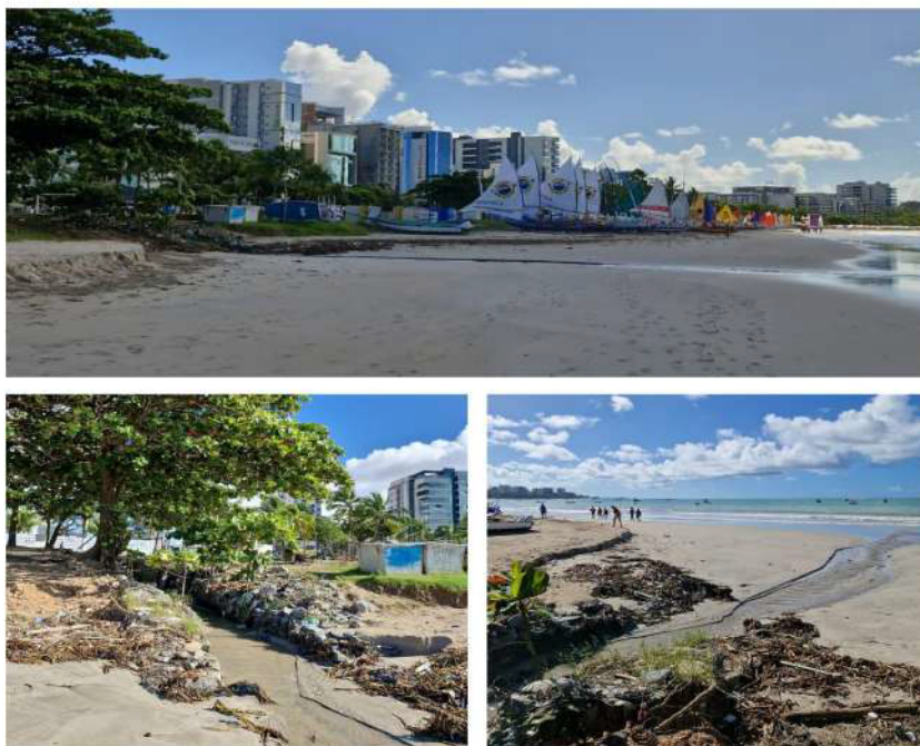
Figura 13 - Saídas de galerias de águas pluviais.
