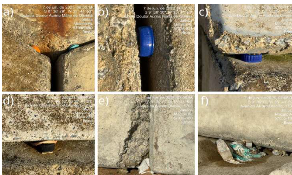
Figura 37. a),b) e c) tampas de garrafa pet presas em contenção com anéis hexagonais; d) tampa de garrafa pet, c) copo descartável e c) fralda presos em contenção de blocos de concreto.
