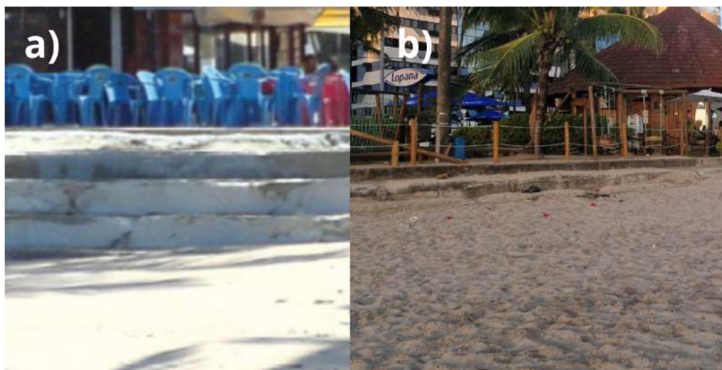
Figura 16 - a) acesso ao estabelecimento Lopana em 2008; b) contenção quase totalmente coberta pelos sedimentos em 2025.
