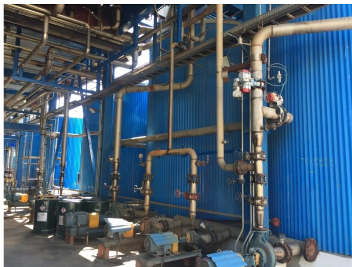
Figura 5: Tanques de armazenamento dos licores.
