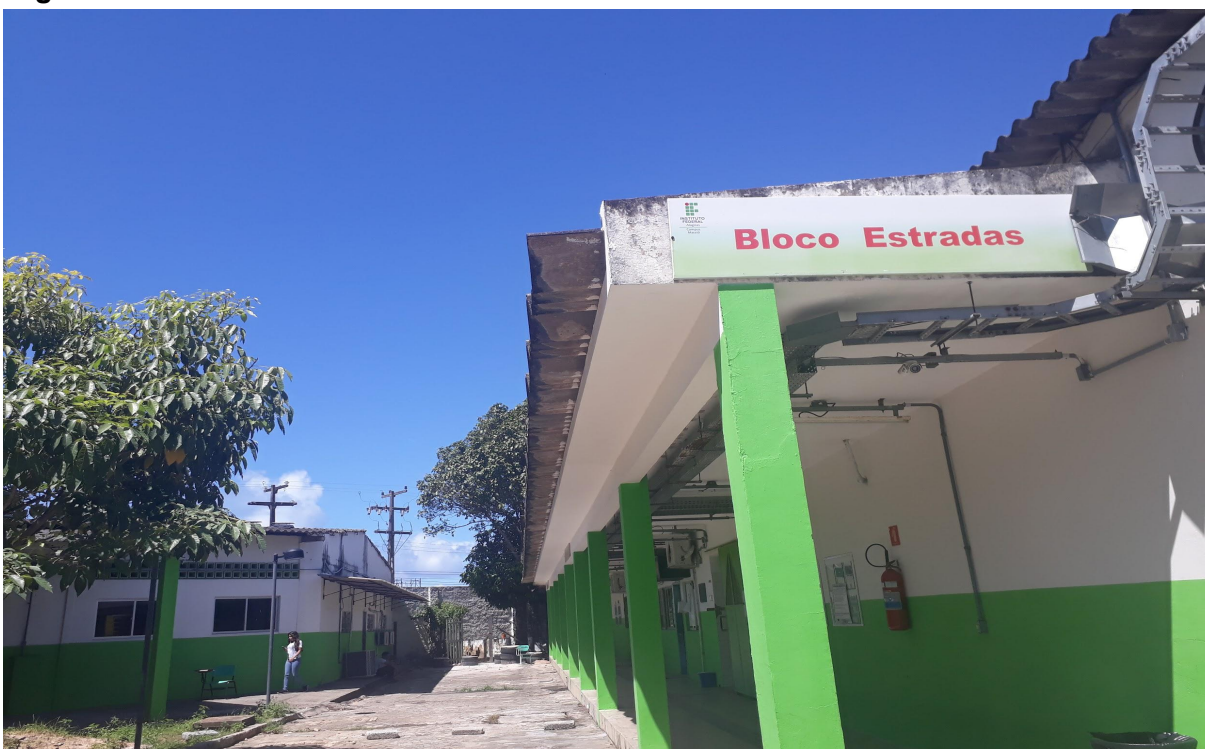
Figura 4 - Placa do bloco de Estradas
