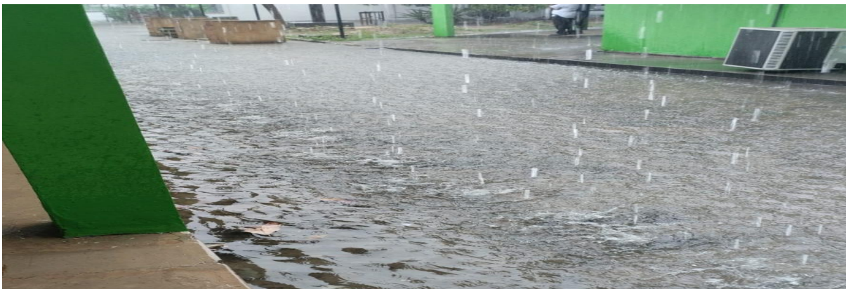
Figura 2 - Bloco de Estradas alagado
