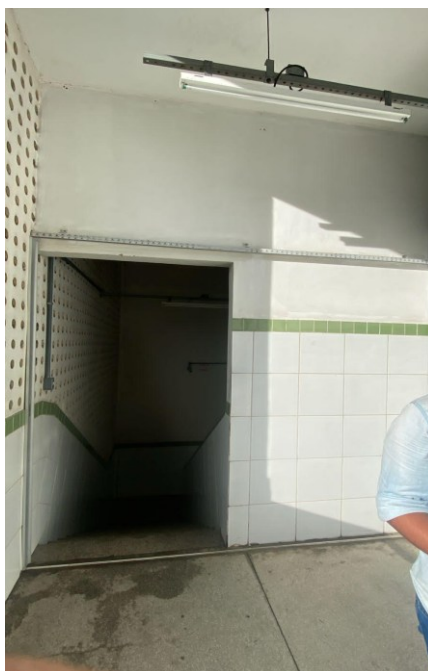
Figura 11 – Vãos de saídas de emergência.
