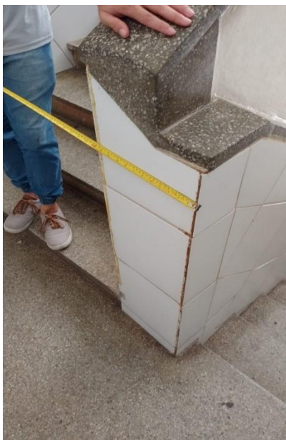
Figura 15 – Medição dos patamares e larguras entre lanço de escadas.
