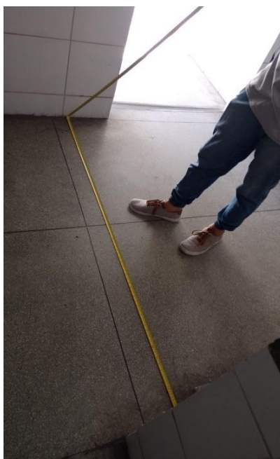
Figura 16 – Medição dos patamares e larguras entre lanço de escadas.
