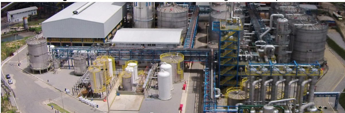
Figura 4: Usina Bioflex localizada em São Miguel dos Campos.
