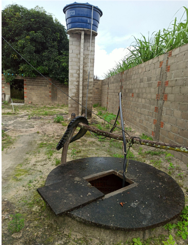
Figura 3: Vista externa do poço do ponto 3
