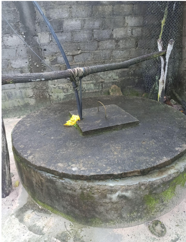
Figura 4: Vista externa do poço do ponto 10
