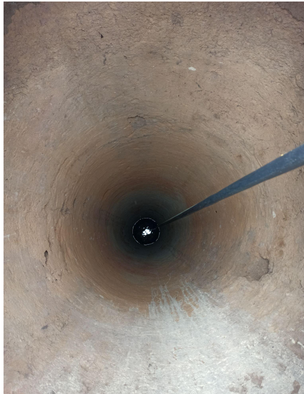
Figura 5: Vista interna do poço do ponto 3
