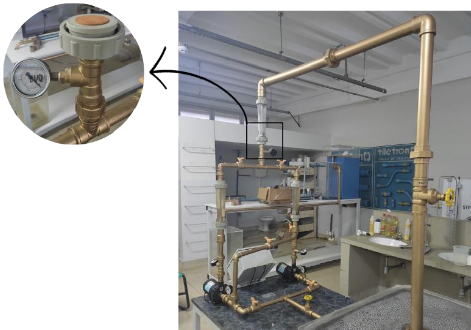
Figura 28 - Equipamento de Associação de Bombas para realização do teste de fluxo permeado
