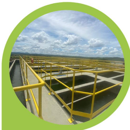
Figura 5 - Floculadores da ETA do Complexo Morro do Gaia
