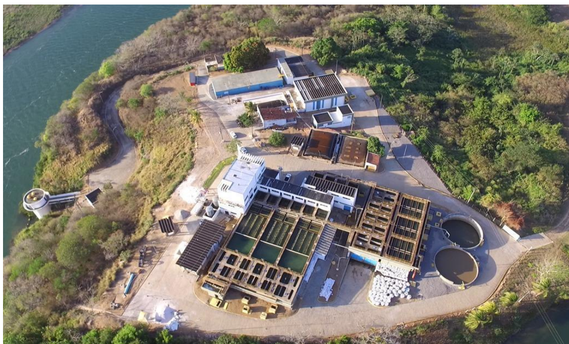
Figura 3 - Instalações das duas ETA do complexo Morro do Gaia em São Brás-AL
