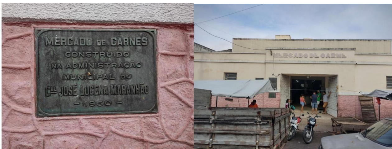
Figura 10 – Fachada do mercado
