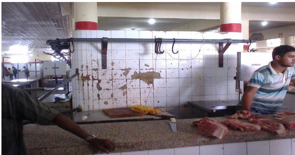
Figura 4 – Observação da estrutura física do mercado
