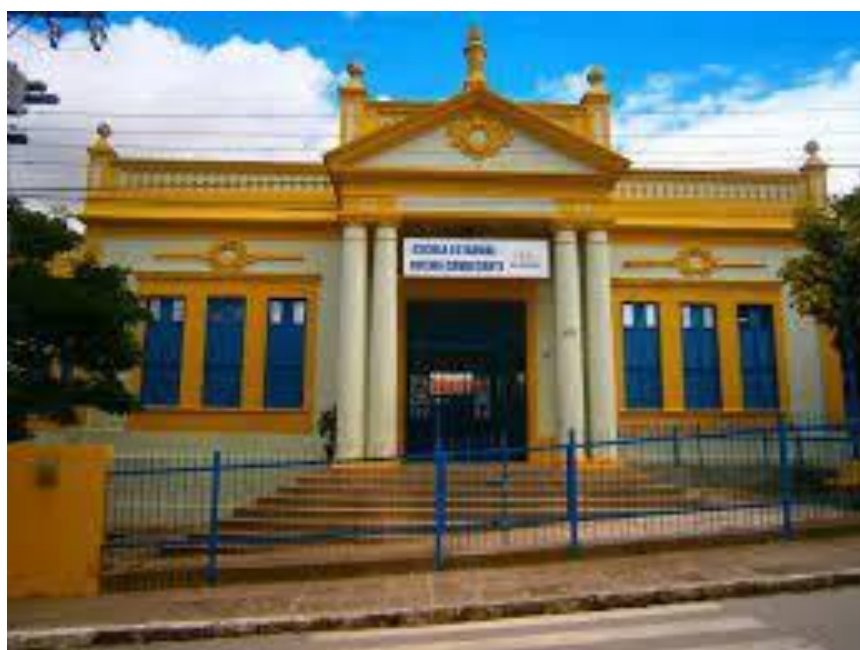
Figura 02: Escola Estadual Rocha Cavalcanti – União dos Palmares/AL.
