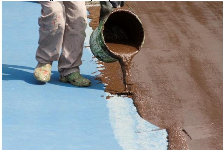
Figura 17 – Aplicação de Lama asfáltica
