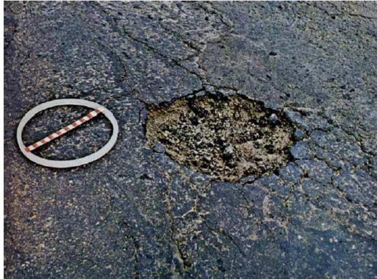
Figura 12 – Panela ou Buraco
