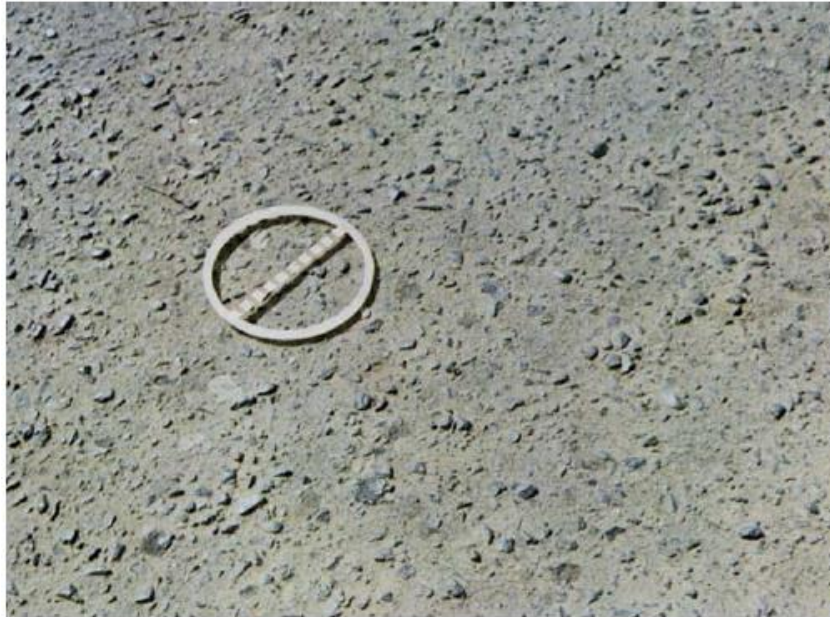
Figura 11 – Desgaste
