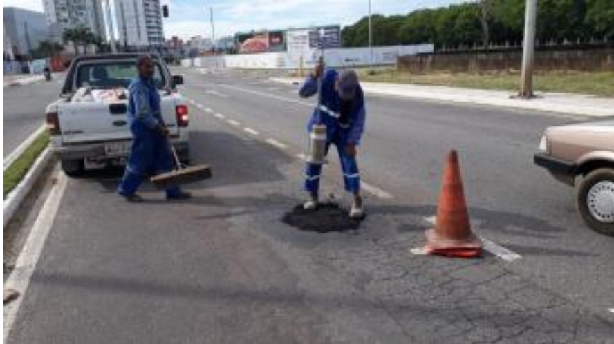
Figura 18 – Correção de pontos localizados ou recapeamento
