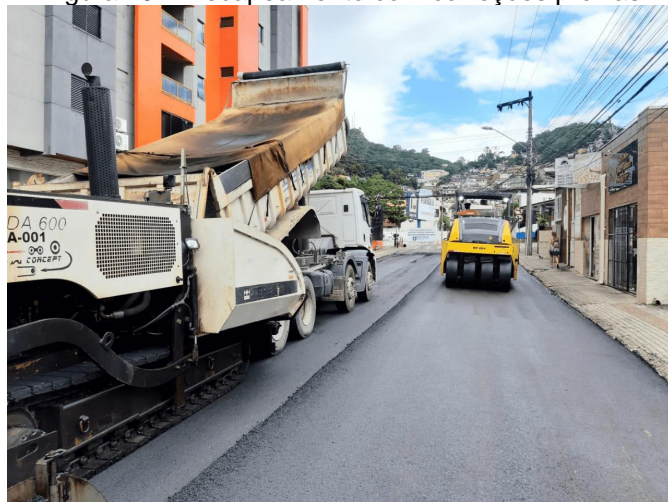
Figura 19 – Recapeamento com correções prévias
