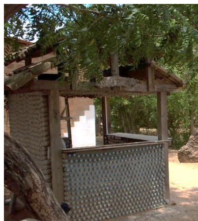
Figura 17: Espaço construído com garrafas pet
