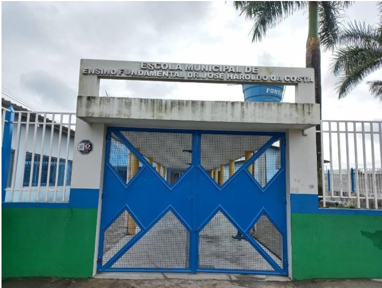
Figura 1 – Fachada da Escola Municipal Dr. José Haroldo da Costa.
