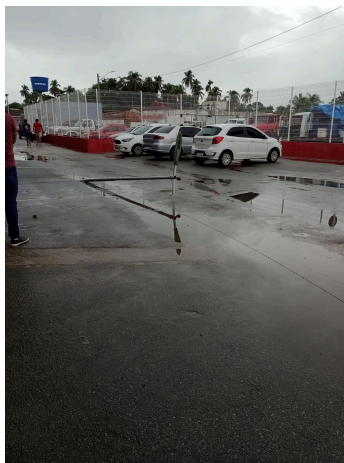
Figura 22 – Poste caído no pátio da feira devido às chuvas. Fonte: As autoras, 2023.
